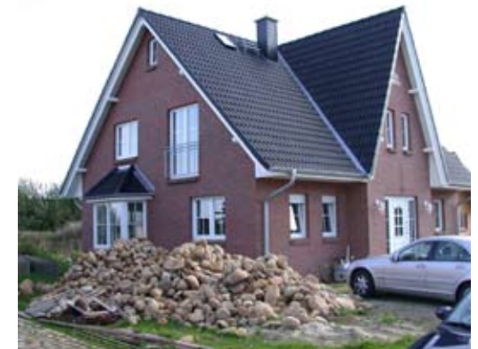
Neu bebaut: eines von 400 Grundstücken
