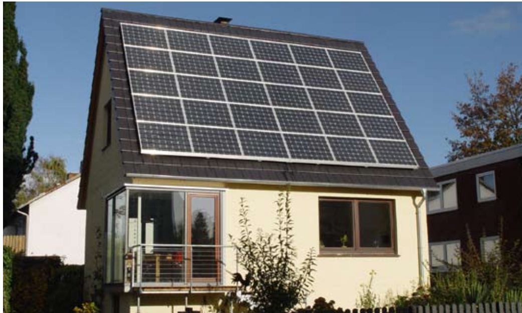
Investition mit Weitblick: Mit Solaranlage die Umwelt und den Geldbeutel schonen
