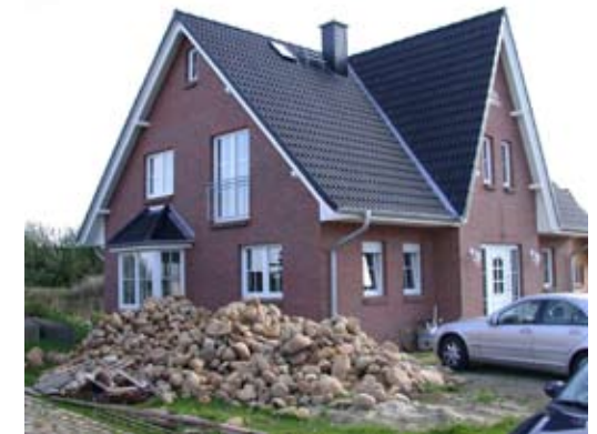
Neu bebaut: eines von 400 Grundstücken
